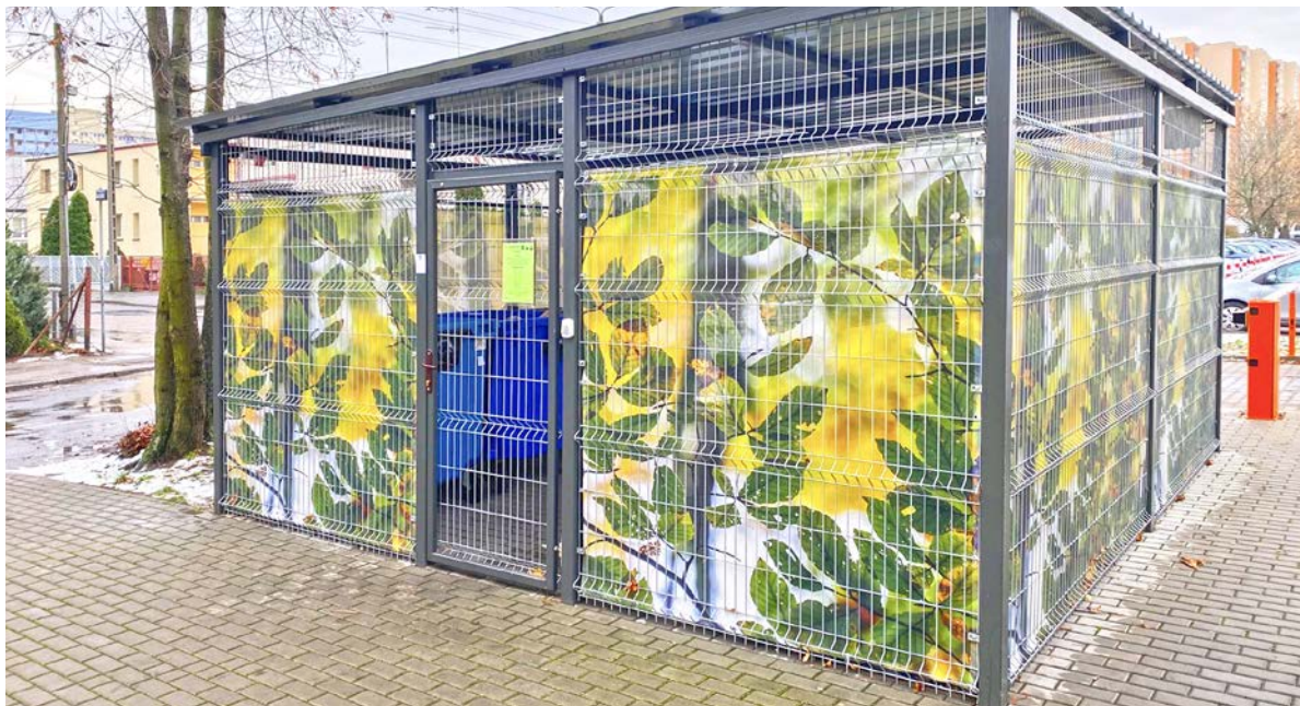
Wiata śmietnikowa przy ul. Żmudzkiej
